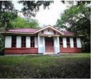
中標津町郷土館緑ヶ丘分館 (旧北海道農事試験場陳列館)
