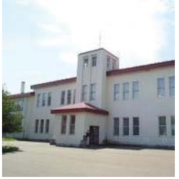
伝成館 (旧北海道農事試験場根室支場庁舎)
