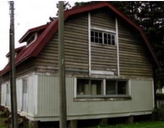
旧北海道農事試験場根室支場 種苗倉庫
