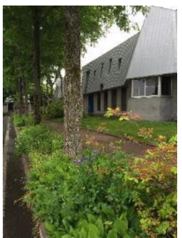
町営住宅計根別団地
