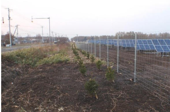
太陽電池発電設備前の緑化修景
