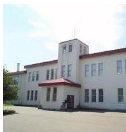
伝成館 (旧北海道農事試験場根室支場庁舎)
