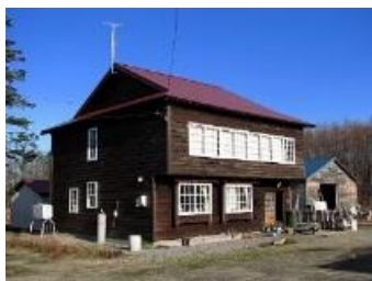
北村邸主屋（旧土田旅館）
