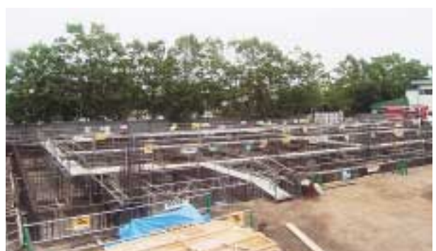
東小学校屋根体工事現場
