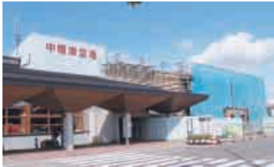
一層の充実をめざす増築中の中標津空港ターミナルビル
