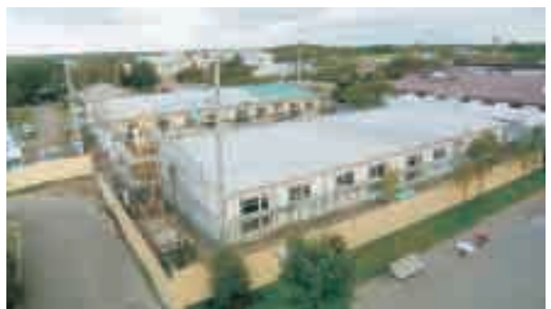
着々と工事が進む計根別公営住宅
