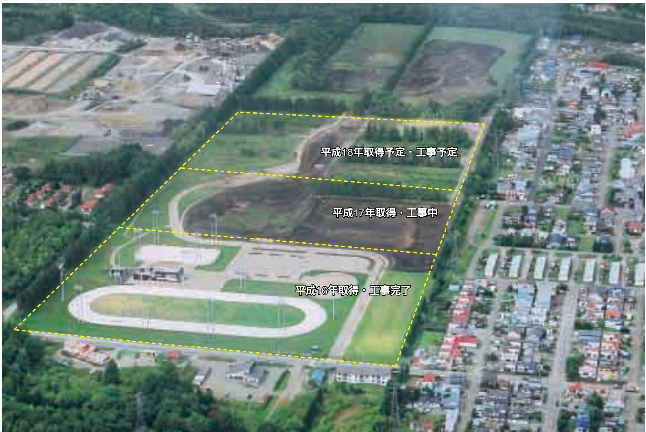
完成がもたれる中標津町運動公園の全景
