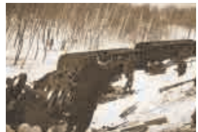
標津線開通後最大といわれた中標津・武佐間の列車転覆事故。負傷者24人を出したが死亡者はなかった
