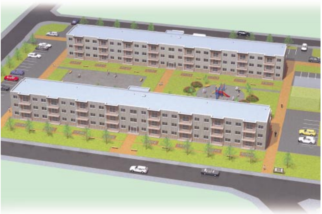
手前が完成間近な西町公住、奥が平成16年度完成予定
