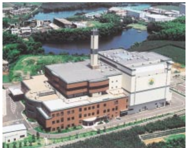
福岡県八女西部クリーンセンター
