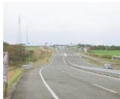
国道272号の完成区間
