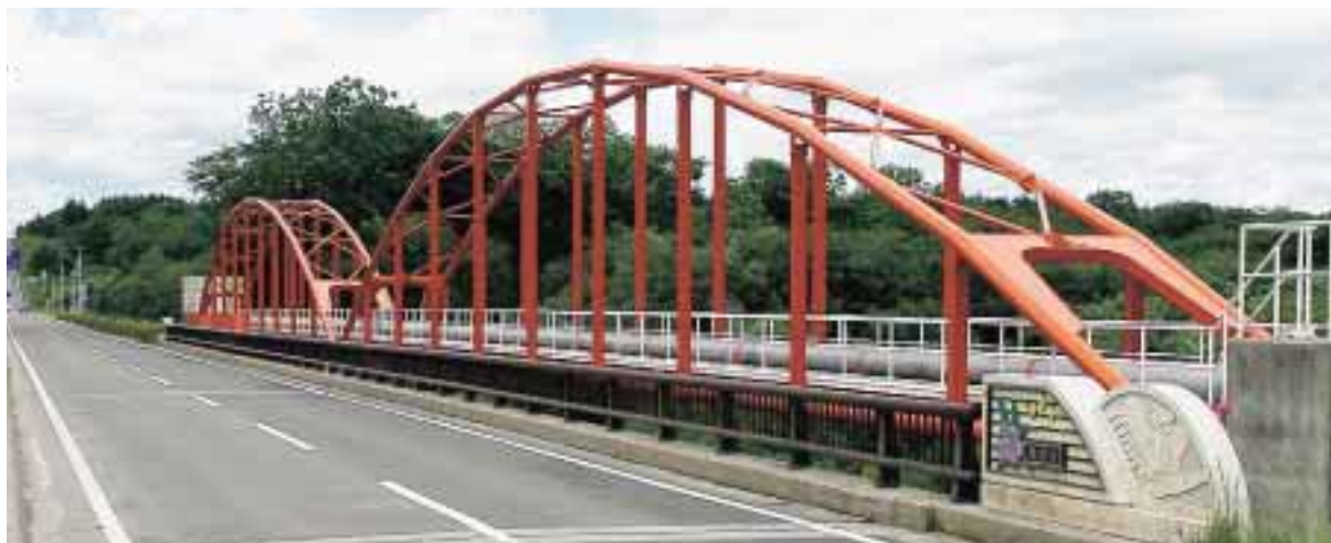
【標津川水管橋（町道28線道路・緑豊橋に並んで架設）】 中標津市街地の水は、この水管橋を通り供給されています。
