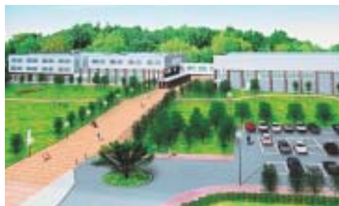
中標津中学校校舎
