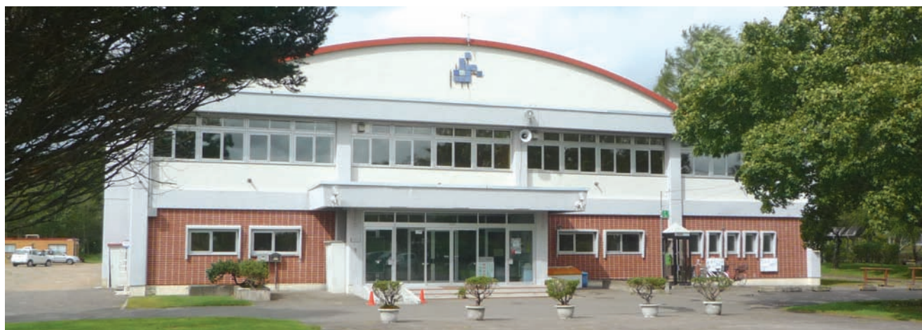
中標津体育館
