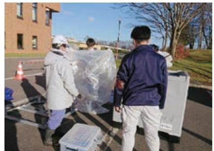
給水コンテナ（容量1m<sup>3</sup>）設置状況
