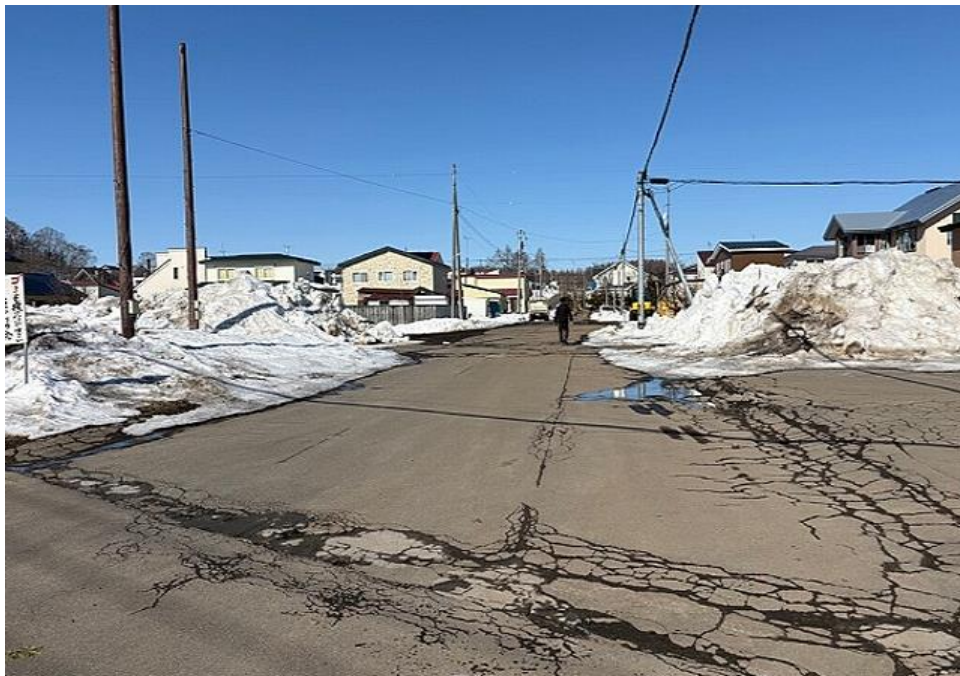
○現地写真(セブンイレブン側舗装道路)
