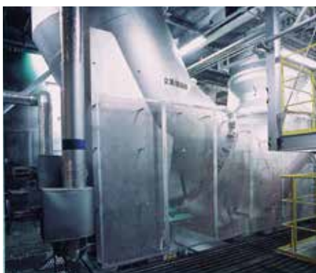
↑溶融炉 溶融してスラグを取り出します
