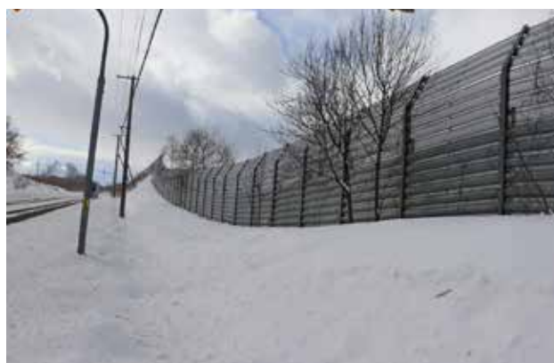
↑ 防雪柵 (吹止柵) ぼうせつさく ふきどめさく
