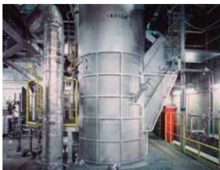
↑ガス化炉 流動床式でごみをガス化します
