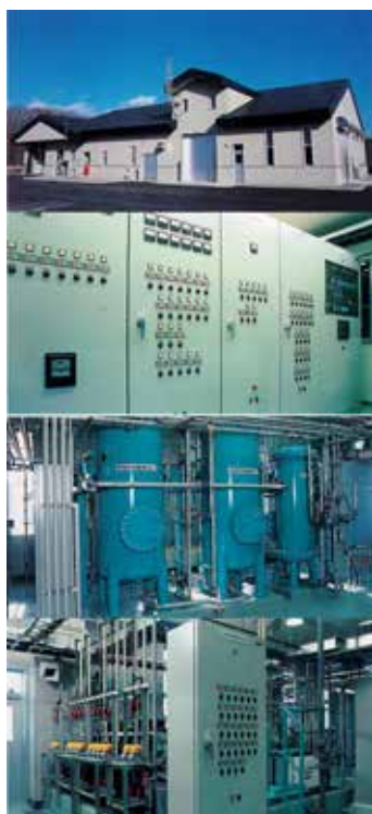
しんしゅつすいしより し せつ ↑ 浸出処理施設
