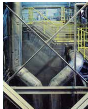
↑バグフィルタ 有害物質を確実に除去し ます
