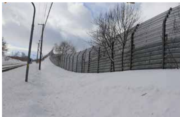
↑ 防雪柵 (吹止柵) ぼうせつさく ふきどめさく
