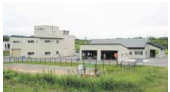
一般廃棄物最終処分場
