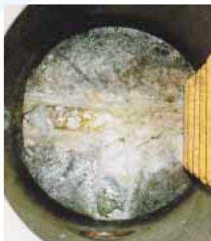
台所で料理に使った油を流すと、下水道管の中でラード状に固まり詰まる原因となります。（写真はマンホールの中）
