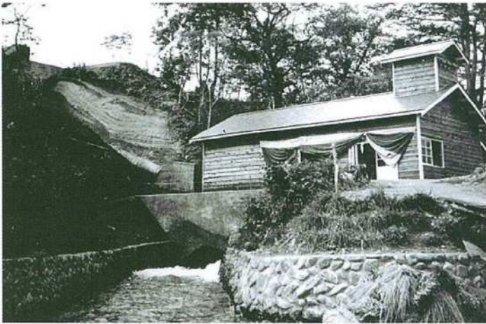
昭和27年10月1日、中標津農協による俣落川の水力発電により、農村の電化が進みました
