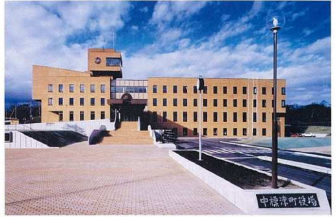
昭和55年10月20日、3代目となる現在の町役場庁舎が完成しました
