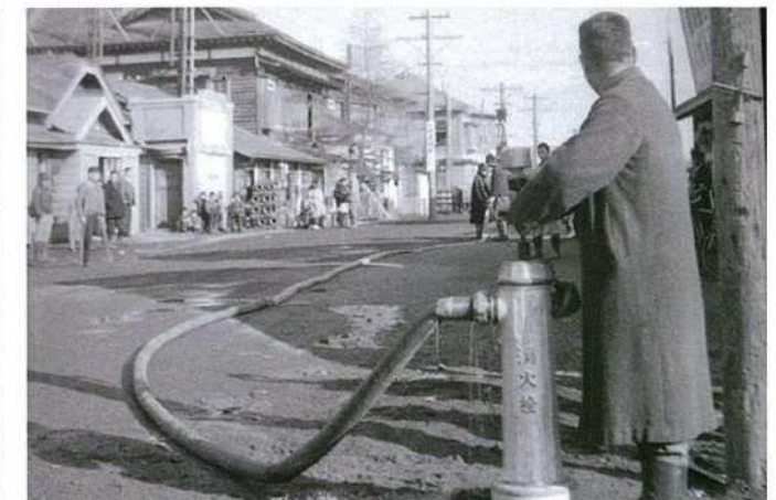
昭和26年11月、中標津市街の上水道が開通しました
