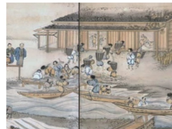
標津番屋屏風に描かれる鮭の水揚げの様子 【新潟県西蔵寺所蔵】
